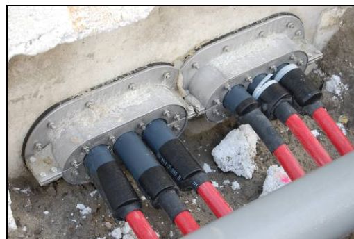
Situatie na plaatsing voorbouwflens
