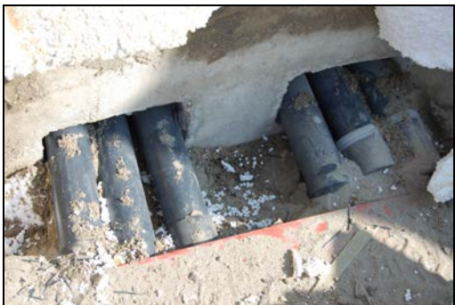
Situatie voor plaatsing voorbouwflens
