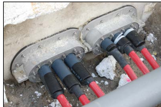
Situatie na plaatsing voorbouwflens
