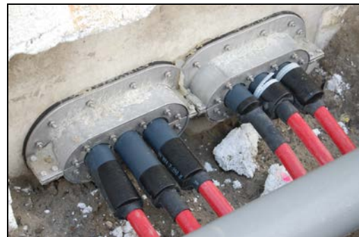
Situatie na plaatsing voorbouwflens
