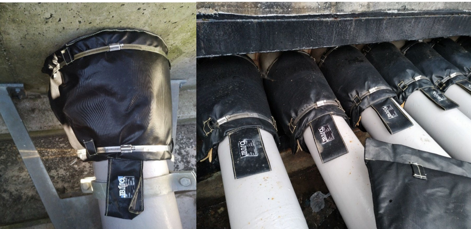
Figuur 4. 3 in 1 Wrap Seals in betonnen tank putdoorvoeren
