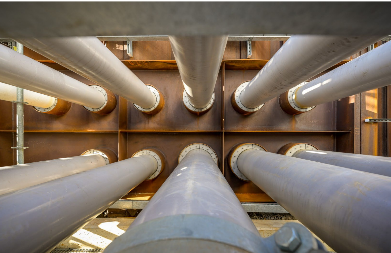
** Figuur 2. Excentrische Seals geïnstalleerd in stalen wand
