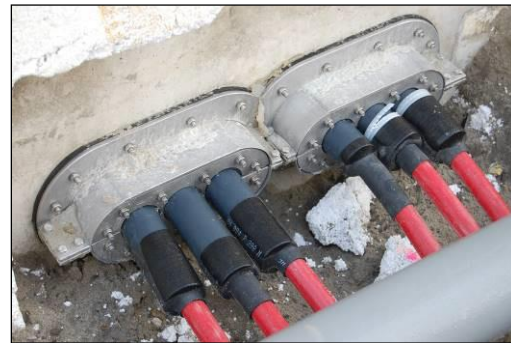
Situatie na plaatsing voorbouwflens
